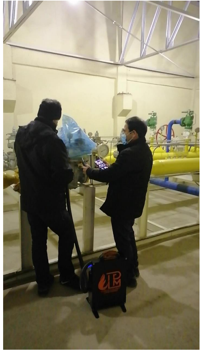
شکل (۱۱): تست های میدانی عملکرد دستگاه در ایستگاه تقلیل فشار گاز جوادیه بجنورد
